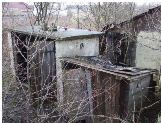
Fot. 8. Najstarsza suszarnia w Szydłowie – widok z góry. W niższej przybudówce znajdowało się zejście do paleniska. Składowano tutaj także drewno do suszenia.
